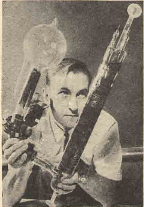
Yoğun mor-ötesi ışınlarını üretmek için yapılan bu gaz Laser'i bio-medikal alanda, kimya endüstrisinde, fotoğraf teknolojisinde çok kullanılacaktır.
