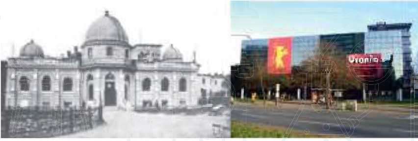
Urania (Berlin) Bilim Merkezi eski (1889) ve yeni binası (2017)
