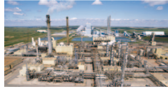
Karbondioksit tutumu günümüzde birçok alanda mevcut teknoloji ile yapılmaktadır. Amerika, Kuzey Dakota'daki santralde karbondioksit ayrıştırma tesisi (sağda). Malezya'daki bir santralde karbondioksit tutum tesisi (solda).
