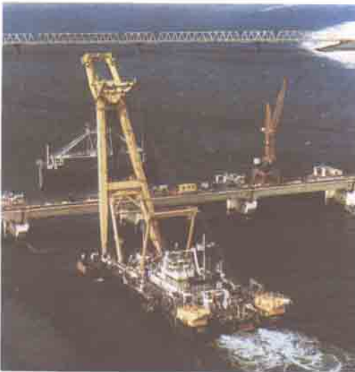
400 tonluk çelik kapı, Taklif 4 tarafından yerine yerleştiriliyor.
