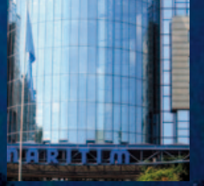
Dış cephe ısı soğuran fümecam kullanımı. Maritim Oteli Bonn, Almanya
