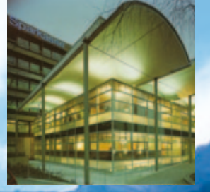
Saydam Kompozit, ısı soğuran fümecam ve Low-e kaplı camların bir arada kullanımı. Savings Bankası Kiel, Almanya
