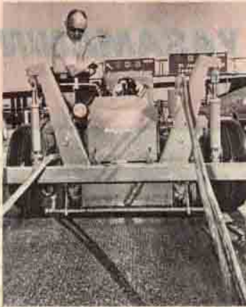
Taşıt hidroplaning'ini azaltmak üzere düzenlenen dişene yivleri, (sağda) NASA (National Aeronautics and Space Administration - Milli Havacılık ve Uzay İdaresi) tarafından hava alan pistleri için geliştirilmiştir. Menleketle ilk kez, tüm bilgisayarla idare edilen trafik kontrol düzeni, SAFER, (en sağda) Apollo programında kullanılan düzenlerden geliştirilmiştir.
