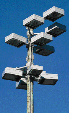
Kentlerdeki bir başka ışık kirliliği kaynağı da yanlış yönlendirilen stadyum ışıklarıdır. Yanda görülen tipteki armatürlerle yukarıdaki spor sahasında yapılan aydınlatmada ışık kirliliğinin önüne geçildiği görülüyor.
