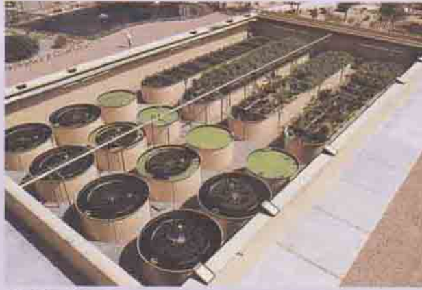
Öndeki tanklarda bulunan mikroorganizmaların başlattığı temizleme işini, arkadaki tanklarda bulunan bitkiler sürdürüyor.
