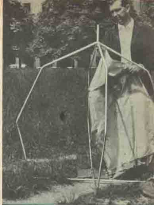
Bir Nüremberg firmasının teklif ettiği şimşek çadır, maddeli çubuklara gerilimle çekilerek kurulmuş ve kâğıtla kaplanmış bir kafesle yapılmıştır. Çadır, kâğıtla kaplanmış ve elektrik gerilimiyle çalışır. Başarı ile sonuçlanan denemelerde çadır 2.000.000 voltlu muntazam fasıllı fanyonlara dayanmıştır.
