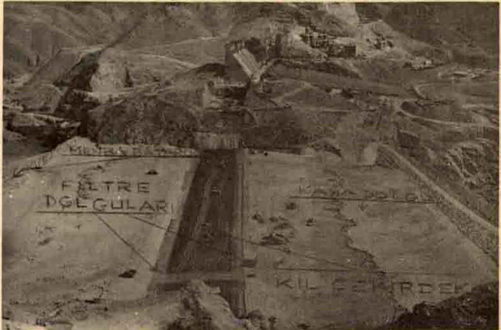
Keban Barajı inşaatının 1970 yılı sonlarındaki durumu..
