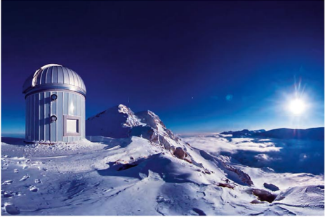
TUG Bakırtepe Yerleşkesi T100 teleskop binası
