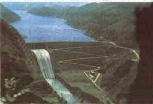
Hasan Uğurlu Hidroelektrik Santrali, Yeşilirmak Nehri üzerinde ve Çarşamba ilçesinin 33 km güneyinde, elektrik enerjisi üretmek amacıyla kurulmuştur.
