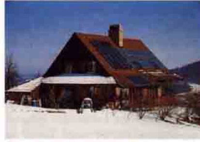
Güneşten elektrik sağlanan ev.
