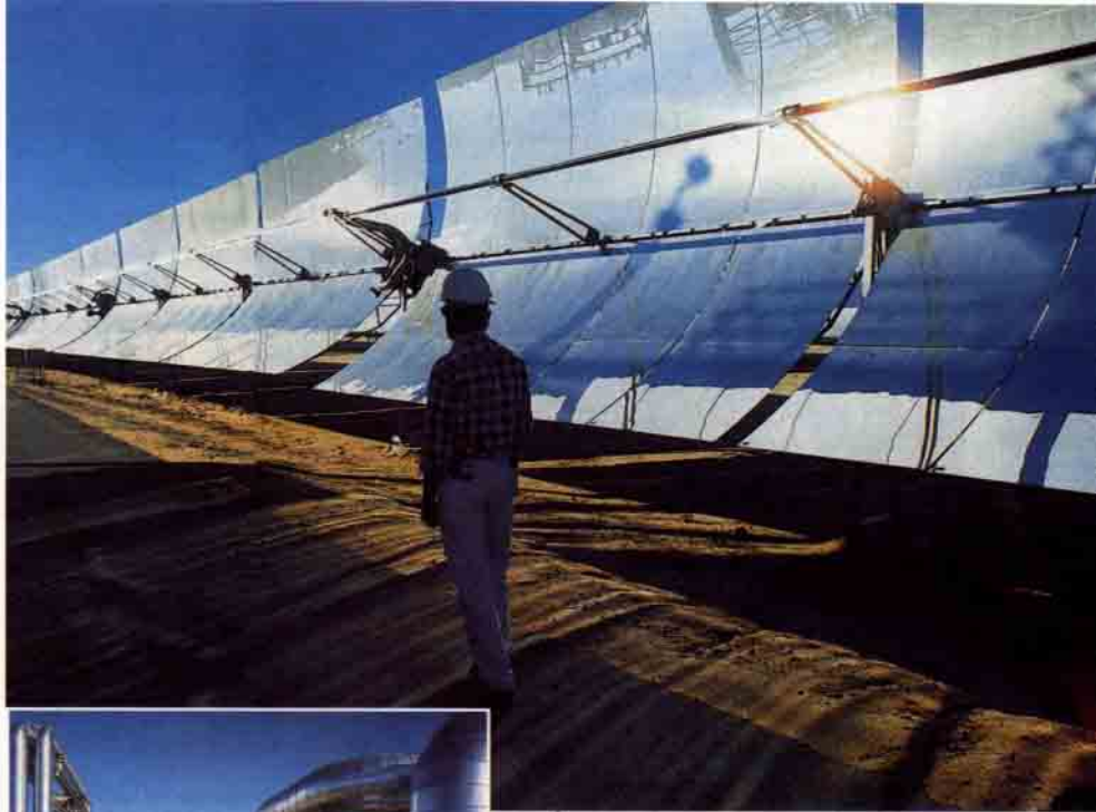
Amerika Mojave çölündeki Luz Santral'i'nde, güneş ışınlarını toplayan parabolik yansıtıcılar ve bu yansıtıcılar yardımıyla ısınan sıvıyı toplayan büyük borular.
