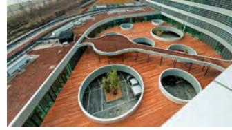
Yeşil binalarda güneş ışınının ulaşamadığı kısımlara doğal ışık kaynağı sağlamak amacıyla ışık boruları (güneş tünelleri) kullanılır.
