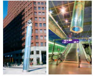
Yeşil binalarda güneş ışınının ulaşamadığı kısımlara doğal ışık kaynağı sağlamak amacıyla ışık boruları (güneş tünelleri) kullanılır.
