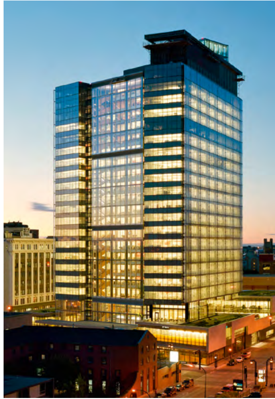
Manitoba Hydro Place, Winnipeg, Kanada (LEED Platin Sertifikalı)
