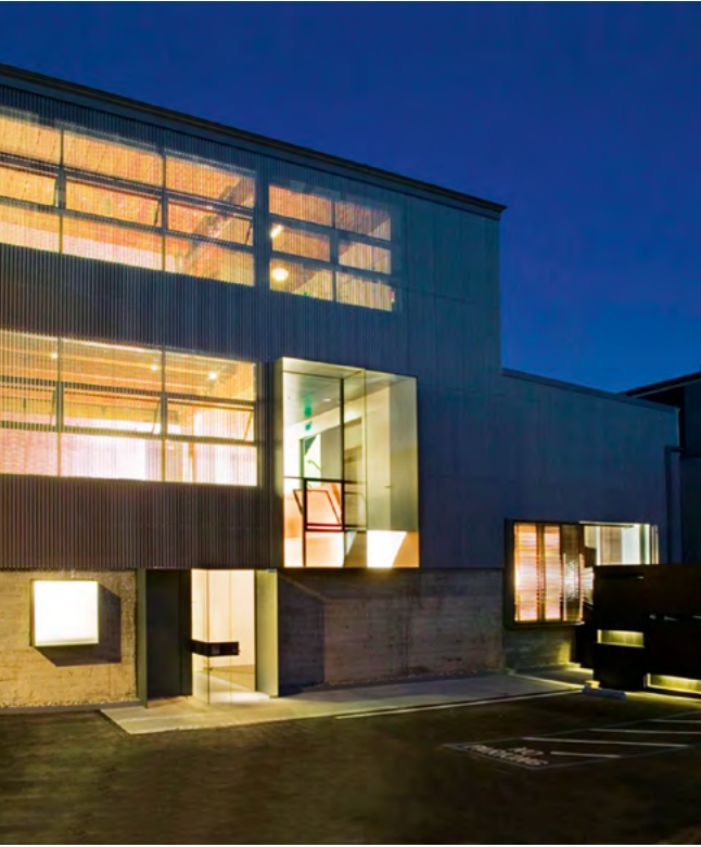
355, 11. Sokak San Francisco, ABD (LEED Altın Sertifikalı)
