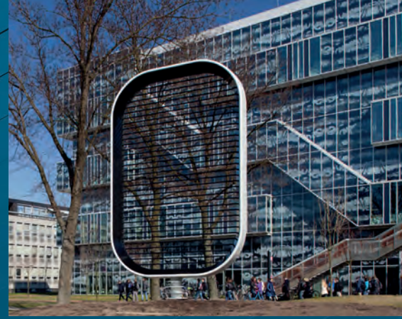
Hollandalı araştırmacılar, yüklü su damlacıklarını rüzgârla iterek elektrik üreten ve hareketli parçası olmayan kanatsız bir rüzgâr türbini olan EWICON'u ürettiler.
