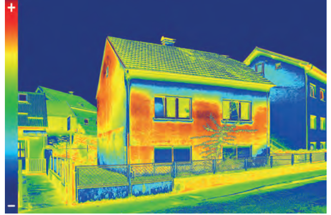
Termal kameralarla alınan bu görüntüde mavi renkteki evde ısı yalıtımı yapıldığı görülüyor.
