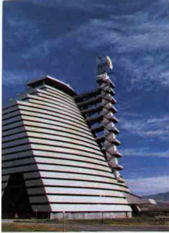
Taşkent'teki bu güneş enerjisiyle işletilen yüksek fı- rında 3000 °C'lik bir sıcaklık sağlanmaktadır.
