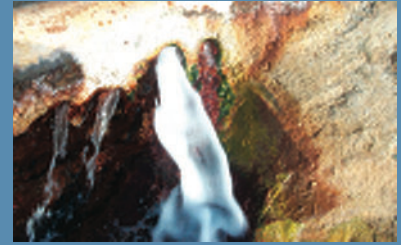
Korozyona uğramış jeotermal sondaj
