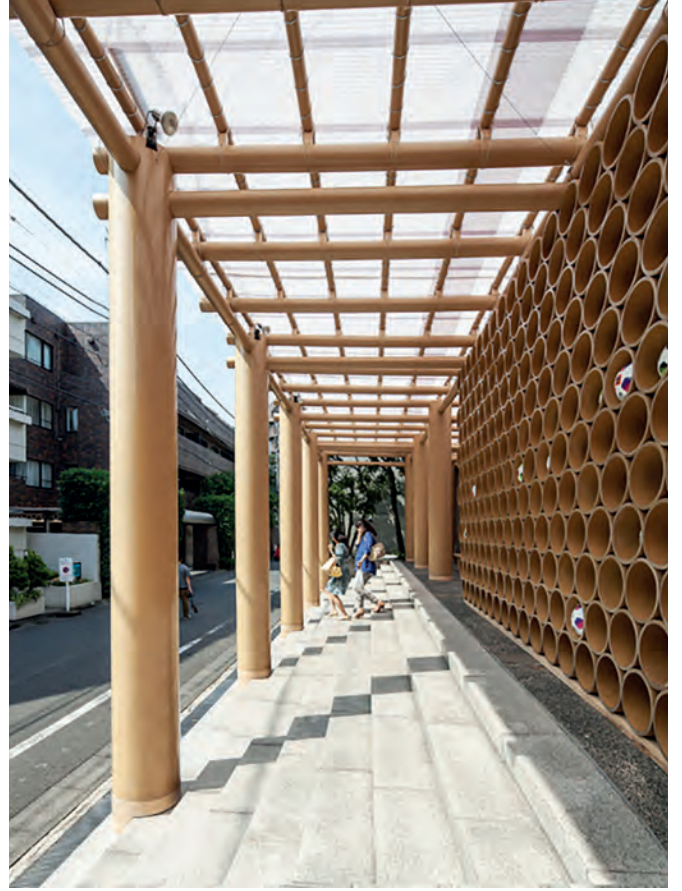
Japon mimar Shigeru Ban'ın poliüretanla kaplanmış mukavva borular kullanarak tasarladığı bir binanın girişi.
