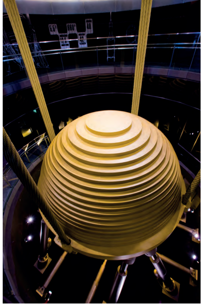
Tayvan'ın Taipei şehrinde bulunan Taipei 101 adlı gökdelen, binanın hareketlerini dengeleyerek hasar görmesini ya da yıkılmasını önleyecek şekilde hareket eden ve 800 ton ağırlığında bir kütle barındıran büyük bir ayarlanmış kütleli damper sistemiyle korunuyor
