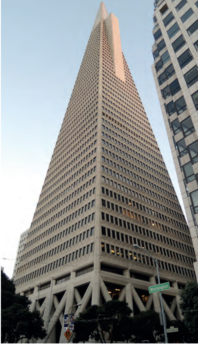
San Francisco'daki TransAmerica gökdeleninin alt kısmındaki çapraz destekler binayı yatay ve dikey kuvvetlerden koruyor.
