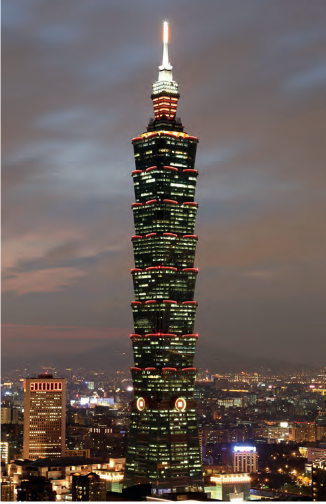
Tayvan'ın Taipei şehrinde bulunan Taipei 101 adlı gökdelen, binanın hareketlerini dengeleyerek hasar görmesini ya da yıkılmasını önleyecek şekilde hareket eden ve 800 ton ağırlığında bir kütle barındıran büyük bir ayarlanmış kütleli damper sistemiyle korunuyor
