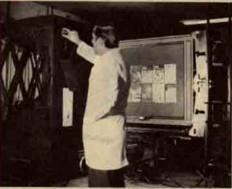
Dergiye girecek sayfaların yatay kamerada filme alınış işlemi.
