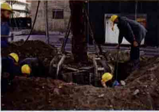
Kök balyasının fıçılama yöntemiyle sağlamaştırılması.
