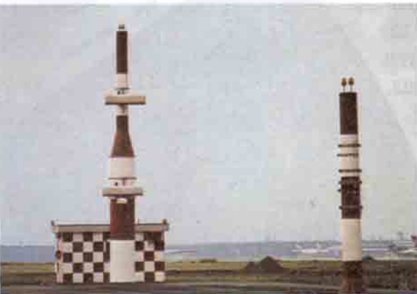
Süzülme rota vericisi: İki çapraz verici anteni, ışınları yukarıya doğru yansıtan düz bir yer alanına doğru yöneltilmiştir.
