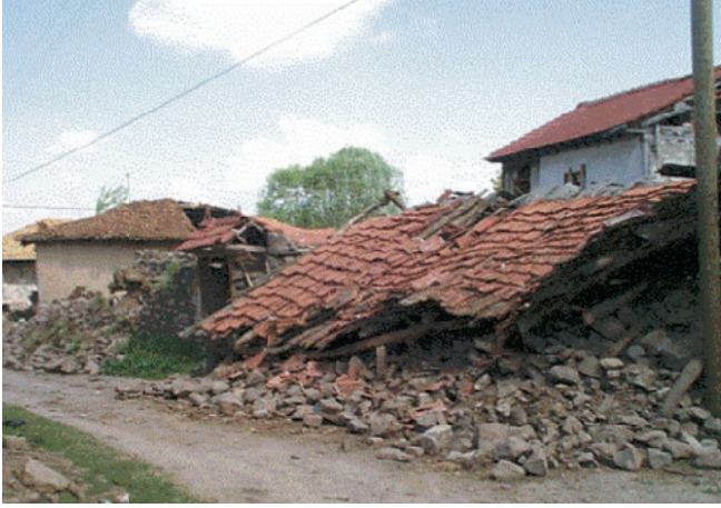
Dodurga'da ağır hasar görmüş kerpiç bir yapı. Dodurga belediye binasındaki hasar, benzer betonarme yapılarda da gözlemlendi.
