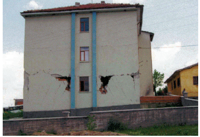
Dodurga'da ağır hasar görmüş kerpiç bir yapı. Dodurga belediye binasındaki hasar, benzer betonarme yapılarda da gözlemlendi.
