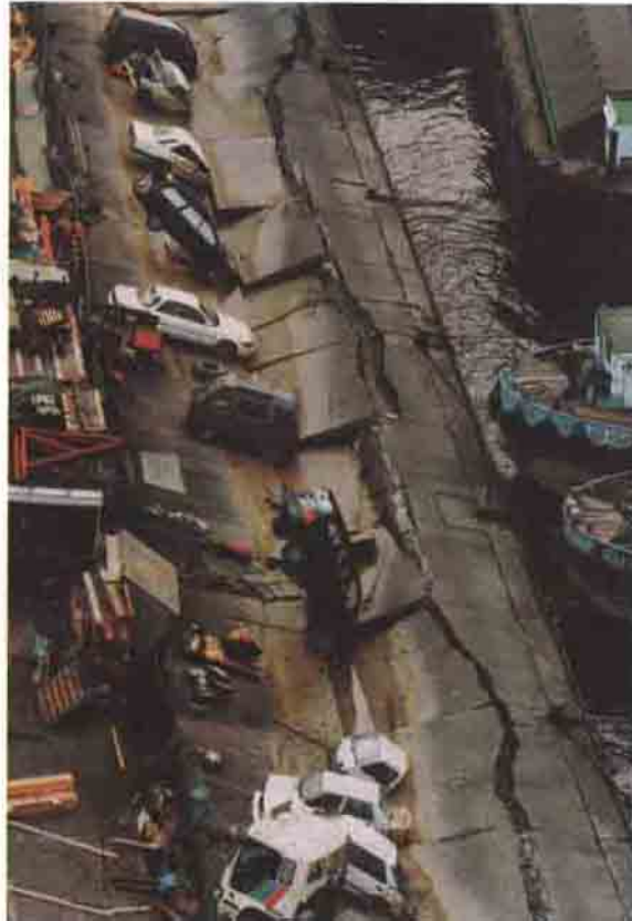
Kobe Depremi sırasında, yaklaşık üç metre çöken rhtm.
