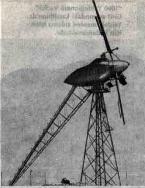
Yalta'daki Rus rüzgâr türbünü 1931'de yapılmıştı. Rotor'un çapı 30 metredir.
