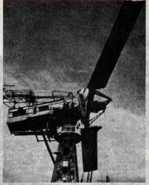
Dünyanın en büyük rüzgâr türbünü 1934'den 1945'e kadar Virginia (ABD) de işletilmiştir. Çapı 53,2 metre, 1250 KW.
