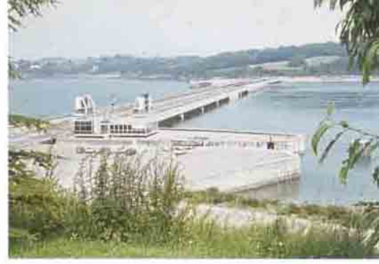
Fransa'da Atlantik Sahilinde kurulu olan Rance, en büyük gel-git hidroelektrik tesisidir. Rance, 240 MW gücündedir.
