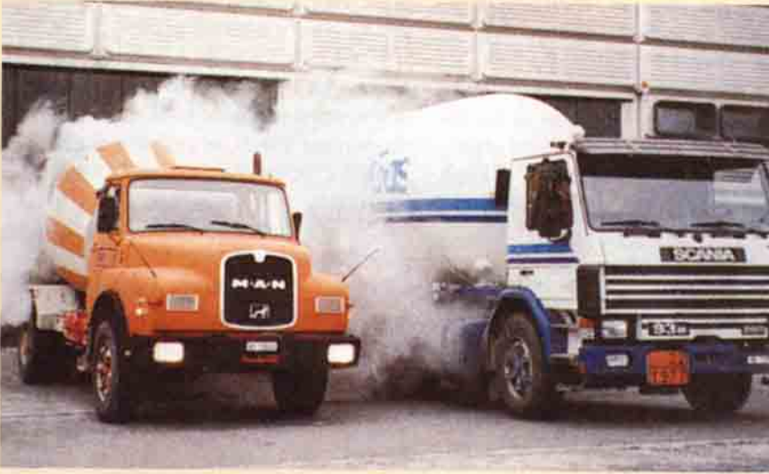
Sıvı azotla soğutulan beton daha az çatlak.
