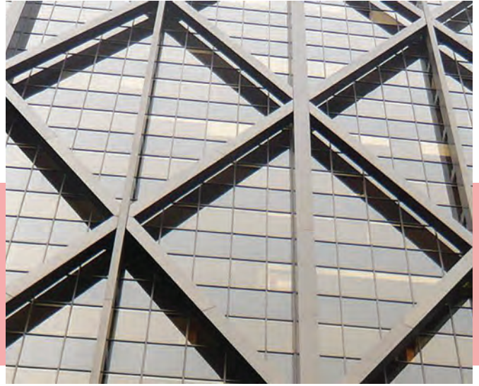
Çelik çapraz çerçeveler depremde kaynaklı kuvvetleri yere iletir.
