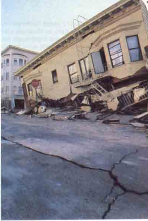
Alt katları garaj olarak kullanılan ve bu yüzden yetersiz miktarda sütun üzerine oturan binalar, San Francisco depremine fazla dayanamadılar (solda). 1985'te Mexico City depremi, birçok binanın yerle bir olmasına sebep oldu (sağda).
