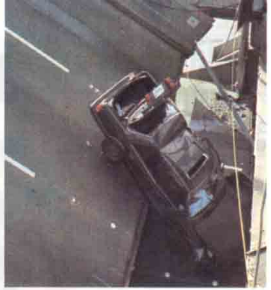
San Francisco'da, 1989'da meydana gelen yer sarsıntısı karayolu köprülerinin depremlere karşı ne kadar dirençsiz yapıldıklarını göstermiştir.
