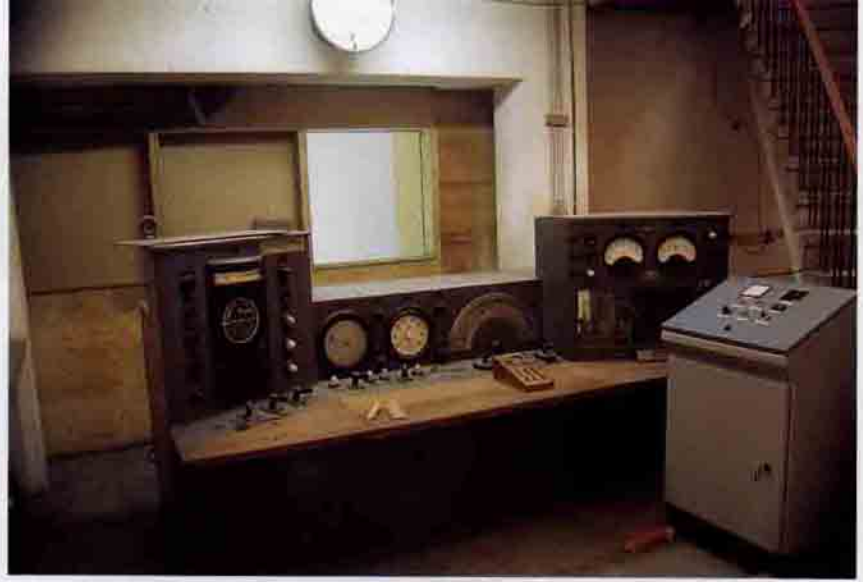
(ART) Deney odasının tünel binası içinde dıştan görünüşü
