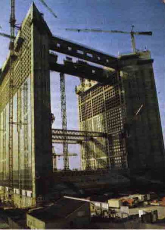
Grande Arche de la Défense binasının yapılışı.
