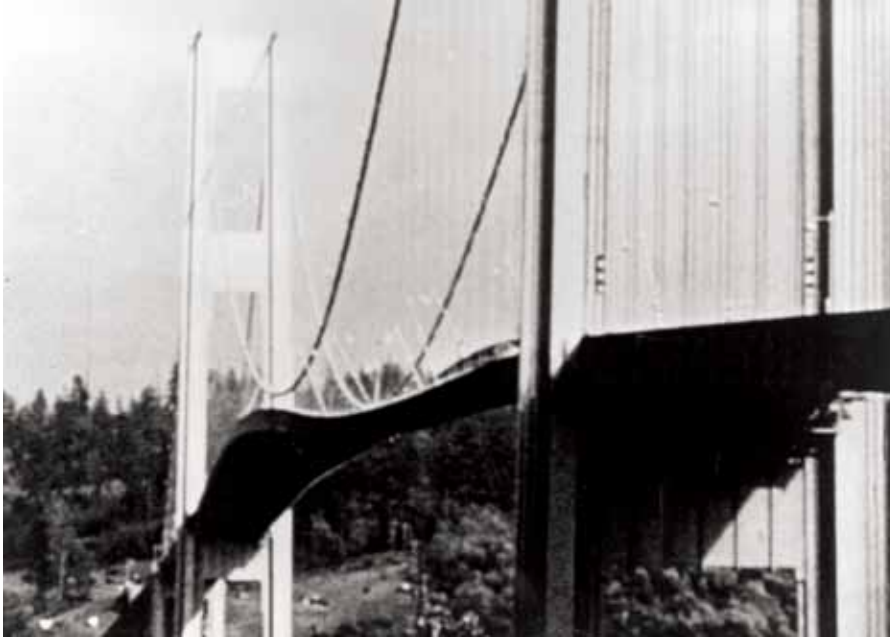
Girdap kaynaklı titreşimler eğer hesaba alınmazlarsa 1940 yılında Tacoma Narrows Köprüsü'nde olduğu gibi büyük yıkımlara neden olabilir.
