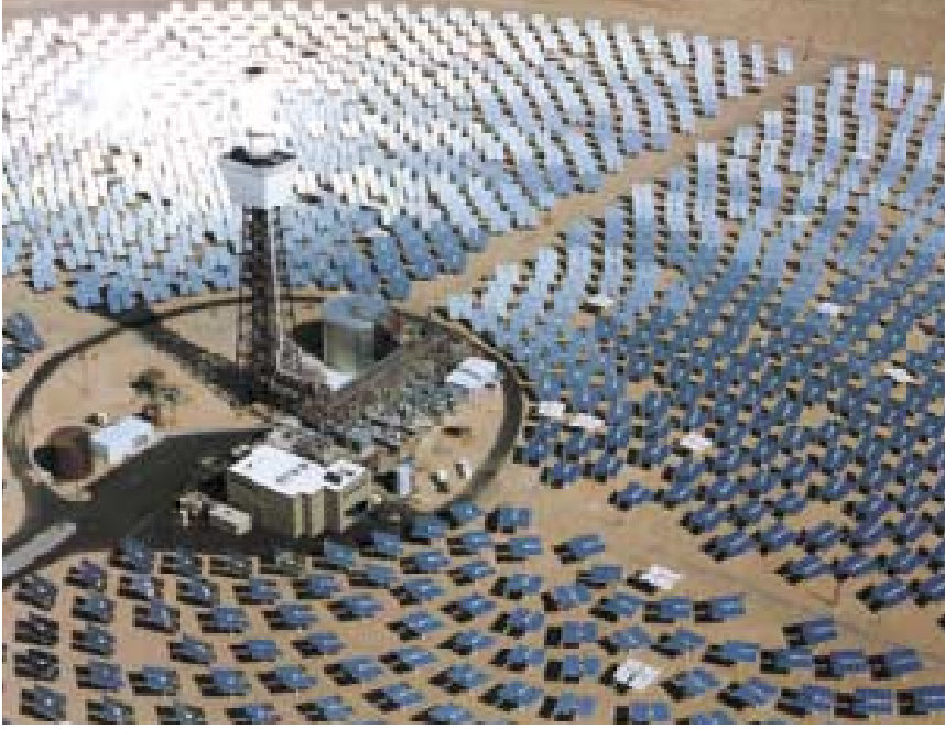
Bir "güneş fırını". Heliostat denen yüzlerce aynadan yansıyan güneş ışını, kulede küçük bir noktaya odaklanıyor. Ortaya çıkan enerji, çeliği eritebiliyor.
