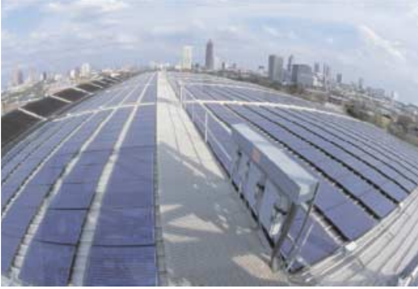
Georgia Teknoloji Enstitüsü'nün su sporları merkezinin çatısında bulunan 3000 fotovoltaik panel binanın elektrik gereksiniminin üçtebirini karşılıyor.
