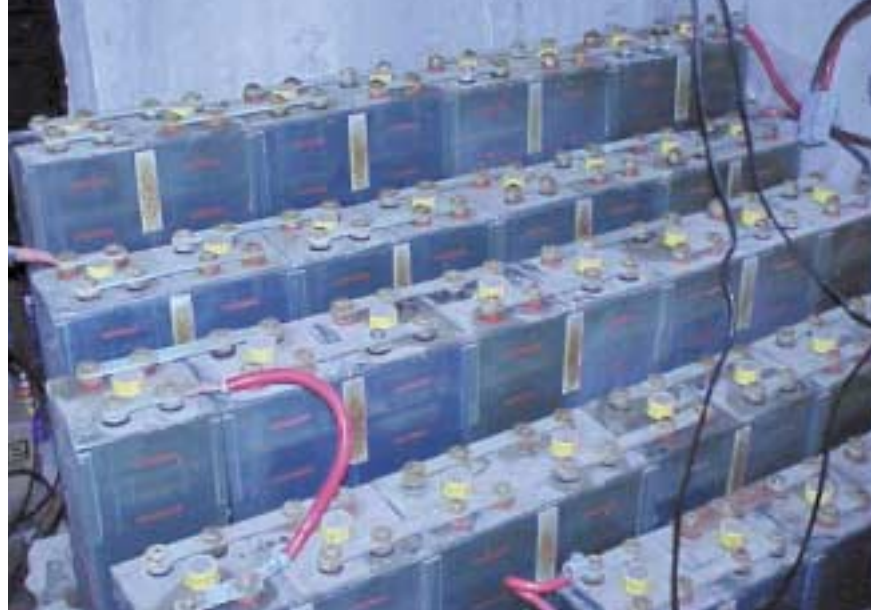
Seri halde bağlanmış nikel kadmiyum aküler
