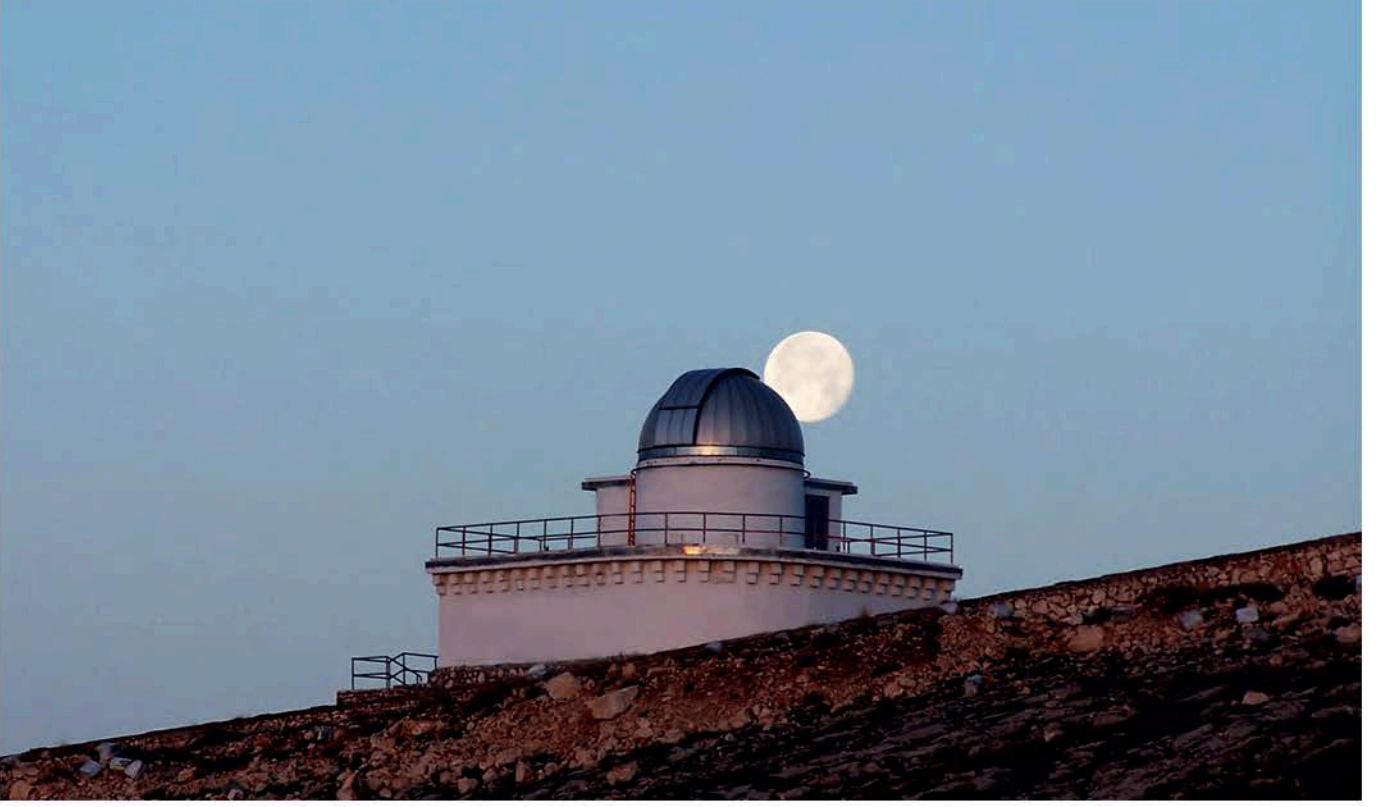
T60 teleskop binası
