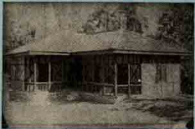
ŞEKİL : 6 Hindistan'da ahşap iskeletli bir dağ evi.
