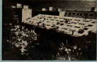
ŞEKİL : 3 Japonya'da 1964 Niigata depreminde devrilmiş olan bir bina.
