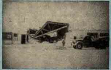
ŞEKİL : 4 Hindistan'daki 1967 Koyna depreminde çatı makası taşıyan bir konstrüksiyonun rijit bağlantı yerinden koparak çökmesi.
