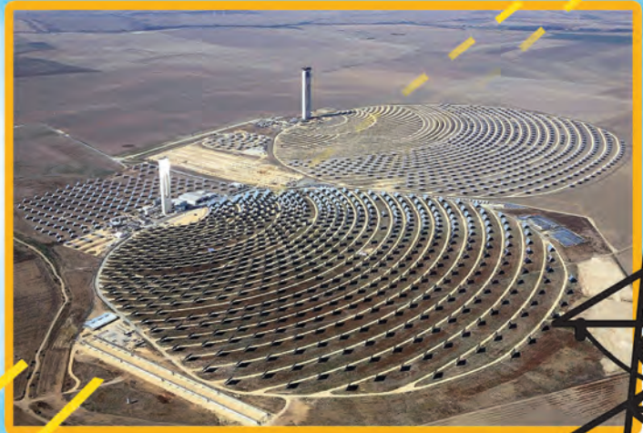
İspanya'nın Sevilla kentinin yakınında bulunan PS10 ve PS20 termal güneş enerjisi santralleri
